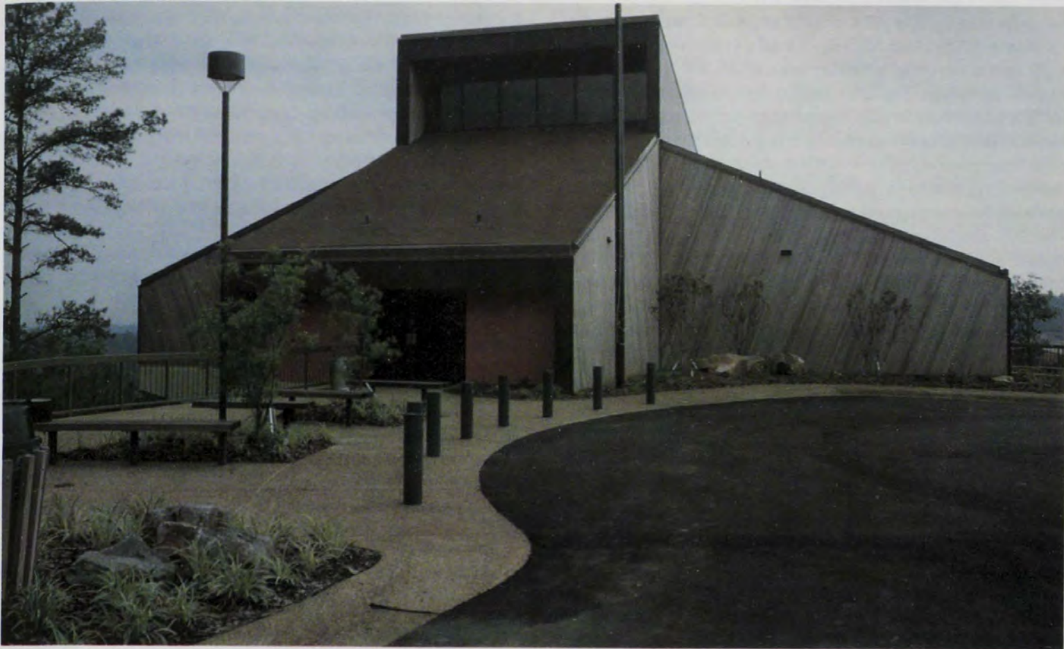
DeGray Lake Visitors Center
